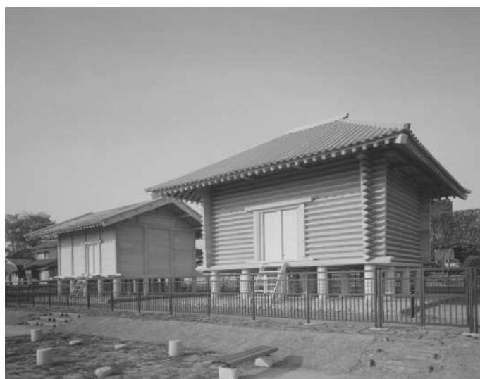
2 号建物（奥） 1 号建物（手前）
